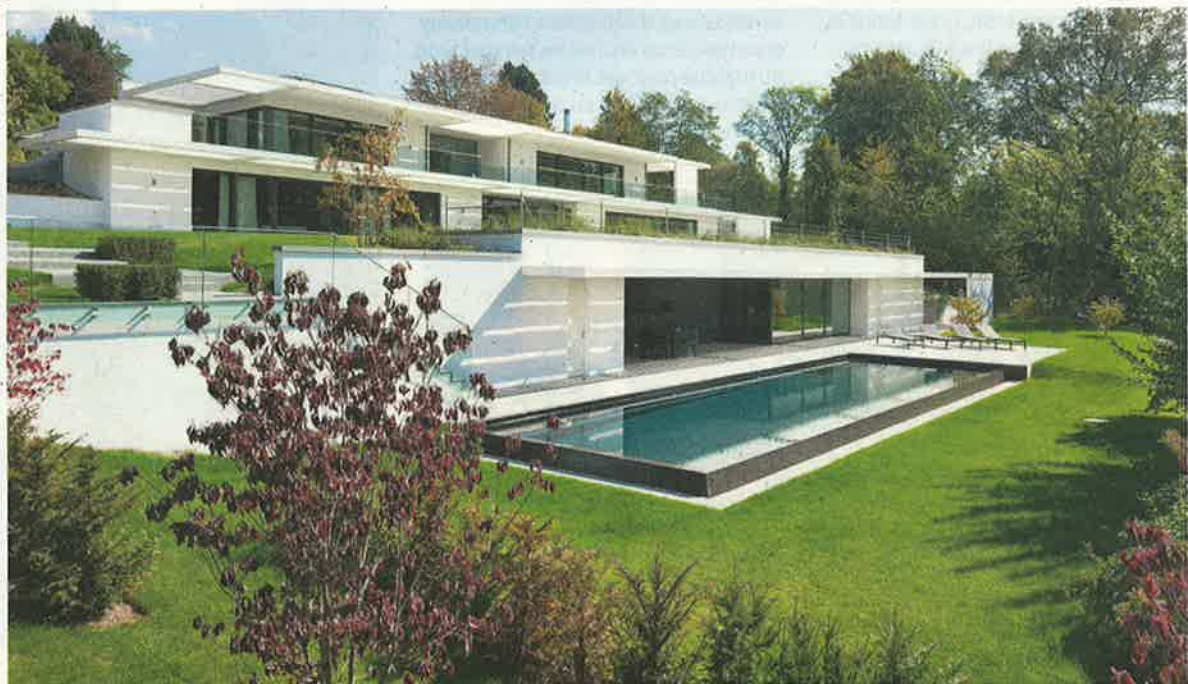
Enveloppée d'une abondante végétation, la villa conserve ses origines et accueille de nouvelles infrastructures adaptées aux exigences du jour. PHOTOS YVES ANDRÉ
